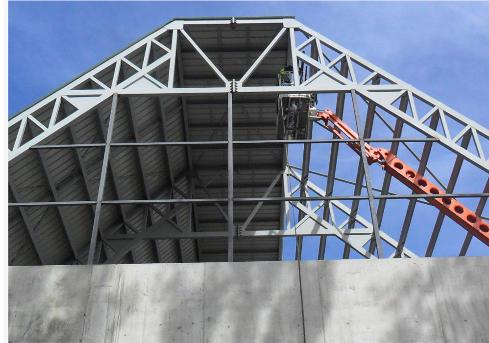
Remodelación de factoría KRONOSPAN, Burgos (2015-2019)
